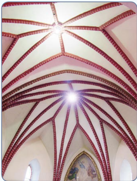
Sklepienie prezbiterium - kościół w Sarnowie (Fot. A.K.)
