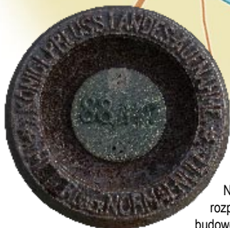
Pruski reper na ścianie kościoła w Wielkim Czystym (Fot. R.G.)
