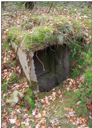
Obiekt o nieokreślonej funkcji (nr 2)
