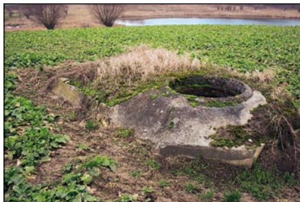
Zgrupowanie schronów RS 58c
