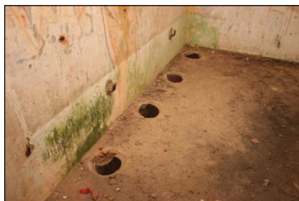
Wnętrze latryny schronu UR 2
