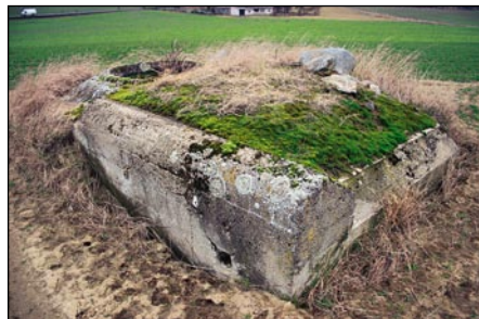
Zgrupowanie schronów RS 58c
