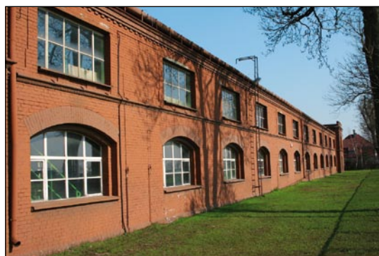
Dwukondygnacyjna wozownia artyleryjska w Stolnie
