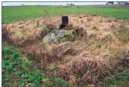
Komin wentylacyjny schronu biernego przy drodze do Rybieńca
