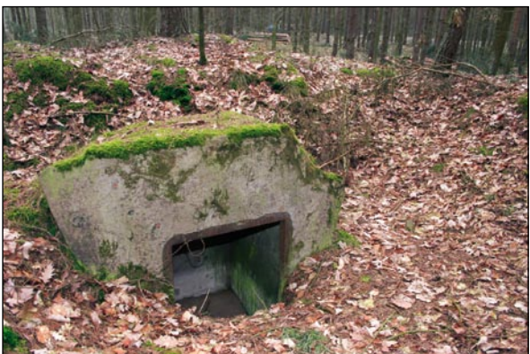
Obiekt o nieokreślonej funkcji (nr 17)
